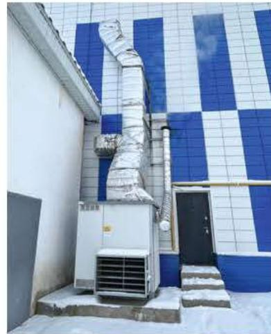
продукты сгорания, и подаётся в помещение спортивного зала при помощи воздуховодов. Система — простая и надёжная, не требует водяного теплоносителя и батарей центрального отопления, а потому относится к энергосберегающим. Топливо расходуется только при работе спортзалов. В остальное время автоматически поддерживается дежурный режим.
